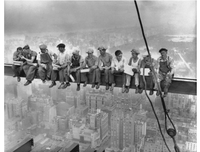
'Hora do almoço'. Fotografia publicitária da construção do arranha-céu Rockefeller em Nova Your, 1932.
